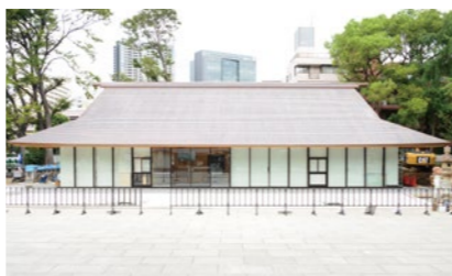
外苑休憩所 (令和元年10月竣工)
