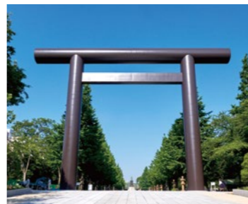
第一鳥居美装 (平成30年12月竣工)
