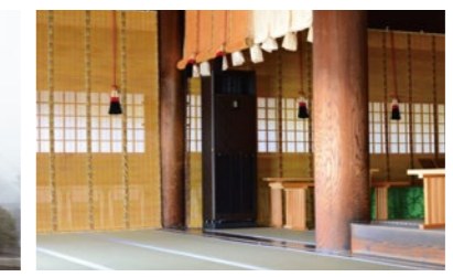
本殿内冷暖房機器(平成30年5月竣工)
