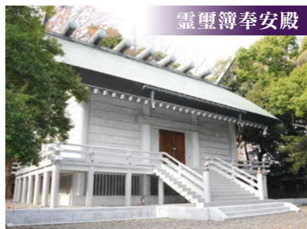
外装を補修し、防水塗装を施す(平成30年12月竣工)
