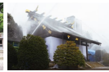
本殿周辺防災設備(平成30年3月竣工)
